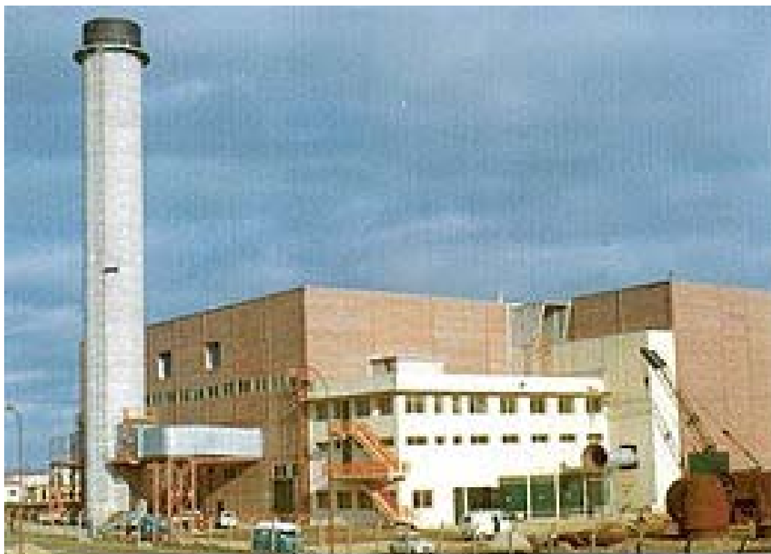
(a) Le Bâtiment C, une imposante installation
