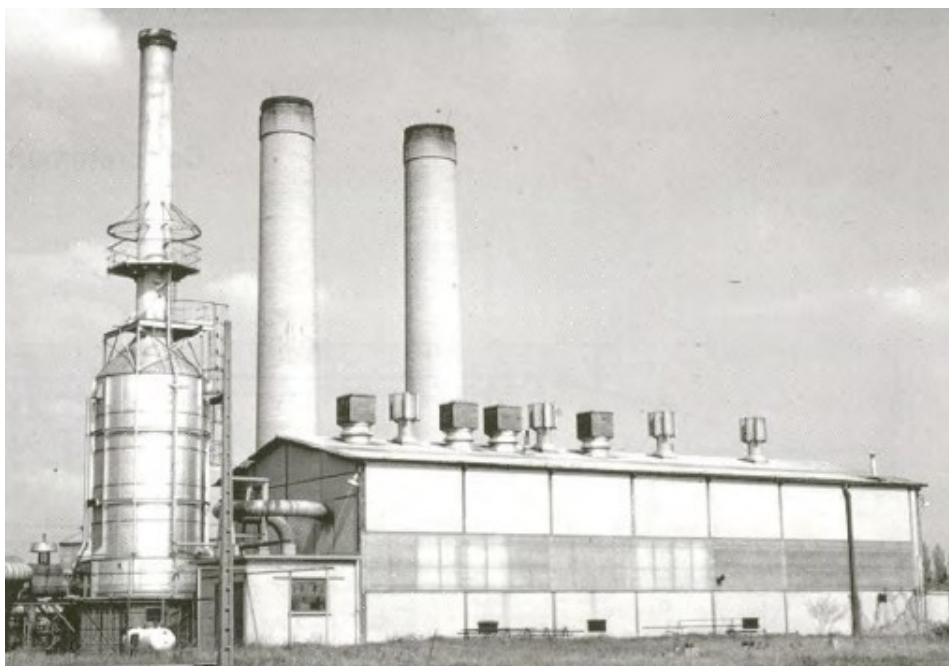
Fig. 7 La chaufferie 2 (chaudières du Montcalm )
