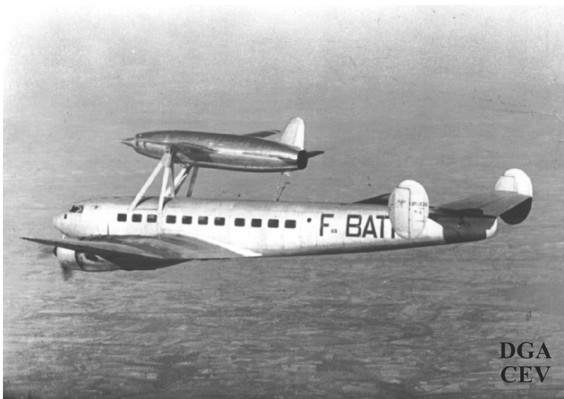
Fig. 4 Avion Leduc 010 sur son avion porteur Languedoc
