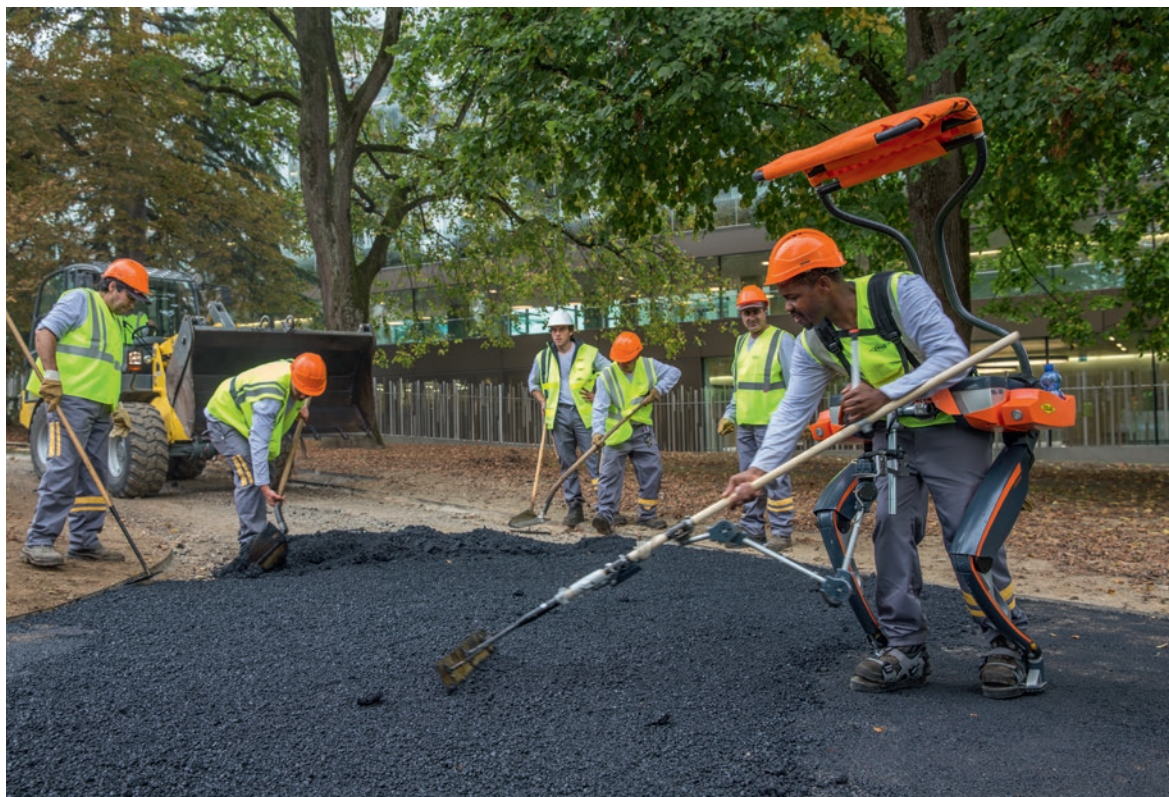
Essais terrain, par Colas Suisse et RB3D (concepteur de cobots), d'un exosquelette sur chantier de voirie à Genève. Filiale : Colas Genève © COLAS - José Campos / Swissmovie.
