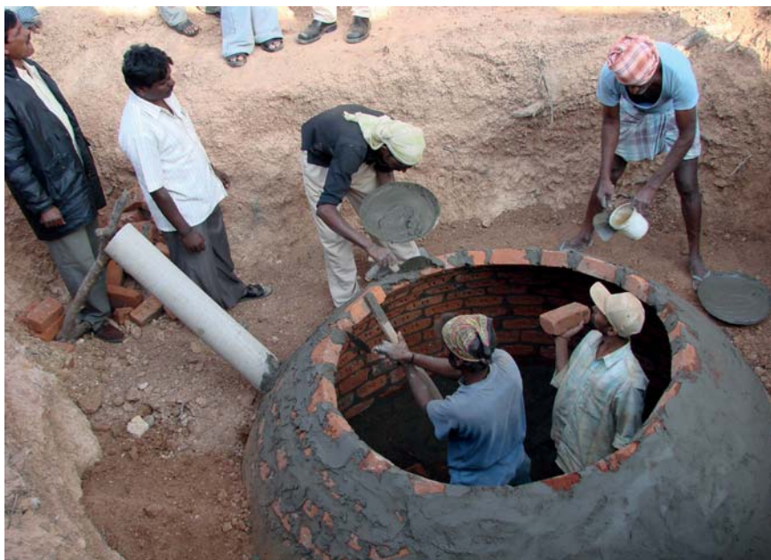
Construction d'un digesteur.
