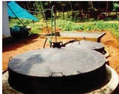
Figure 9: installations standardisées de production de bio-gaz dans les campagnes chinoises (Source: INRA).
