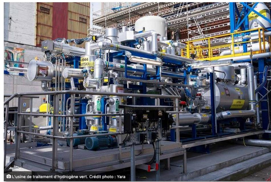
Un grand électrolyseur (24 MW), inauguré récemment, capable de générer jusqu'à 10 tonnes de H<sub>2</sub> par jour. Cette usine située à Porsgrunn, au sein du complexe industriel de Herøya, appartient à Yara International (nutriments pour végétaux sous forme d'engrais cristallisés) et lui permettra de réduire ses émissions de CO<sub>2</sub> de près de 40 000 tonnes par an. L'usine s'étend sur une superficie d'environ 1,5 km<sup>2</sup>
